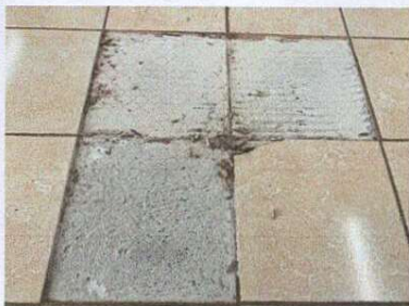
Foto1: Sustitución de piso cerámico levantado y quebrado.
