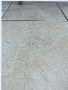
Foto1: Sustitución de piso cerámico levantado y quebrado.
